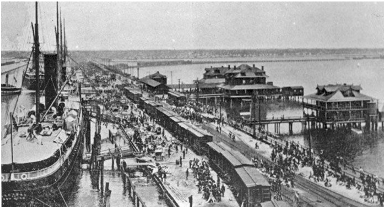
Porto di Tampa Bay con la stazione ferroviaria
