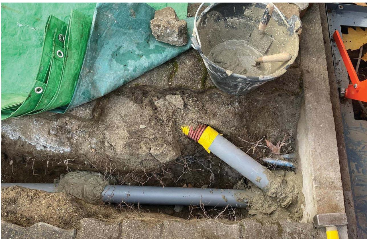
Tubo rigido di 75 mm per il drenaggio (in basso), tubo per la ventilazione (in alto)
