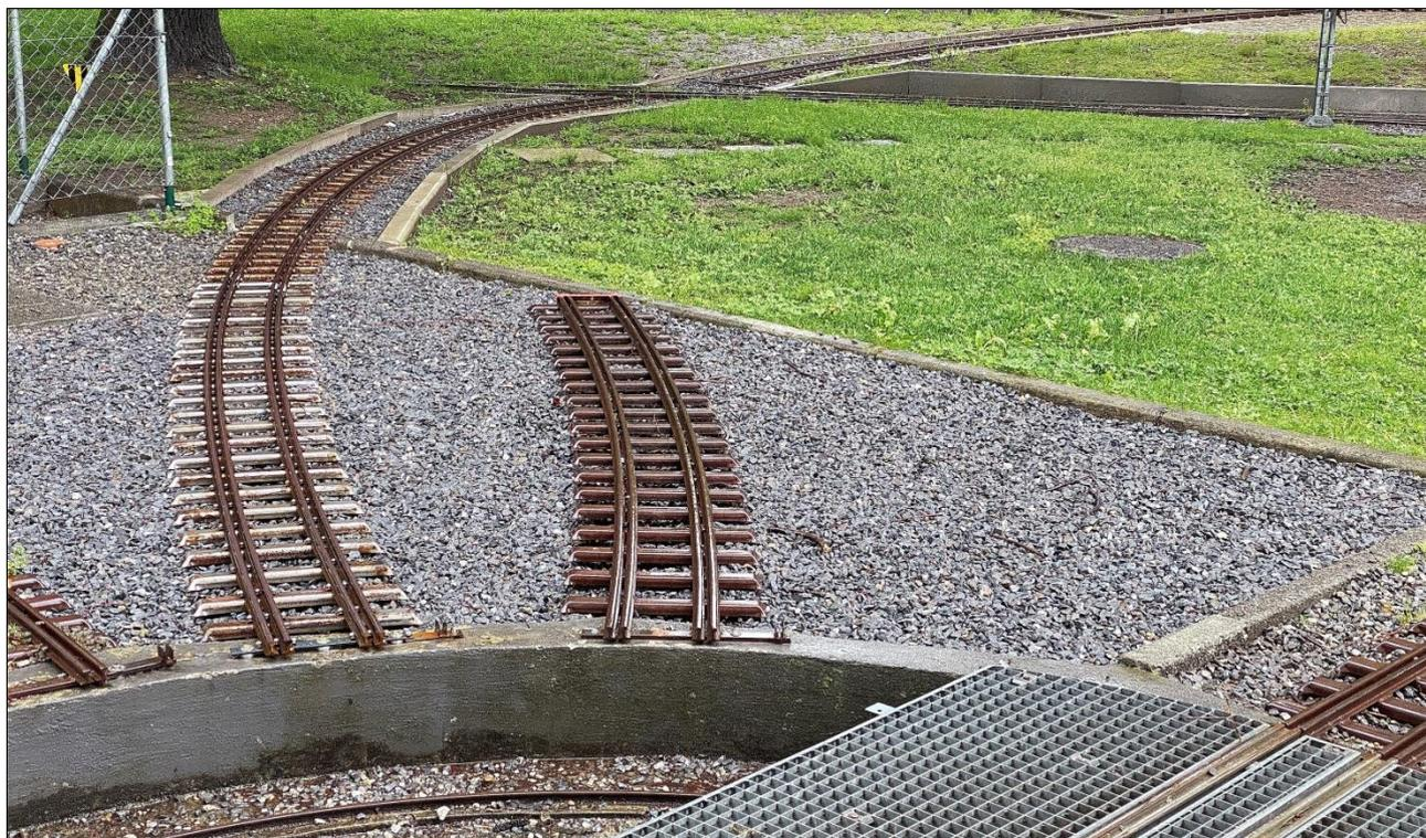
È previsto in seguito di sostituire la parte mobile con un incrocio fisso. La progettazione è già iniziata. L'incrocio è costituito da due linee: una a 3 binari, l'altra a 4 binari. La complessità è dovuta al fatto che tutte le due linee devono rispettare le normative NEM per gli scartamenti 5" e 7 ¼" per permettere la circolazione ad ogni tipo di locomotiva/vagone.
