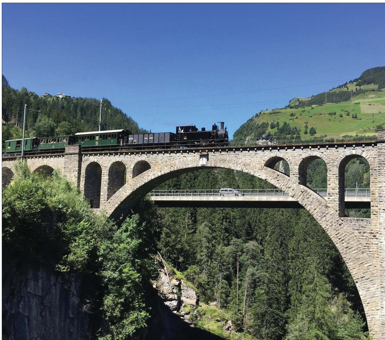
G \frac{3}{4} Nr 11 Heidi con vagoni storici sul ponte di Solis-GR
