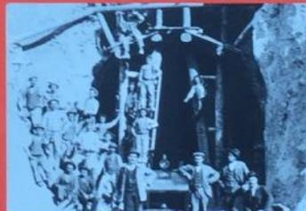
Abstützungen aus Holz zur Sicherung des Tunneleingangs.
