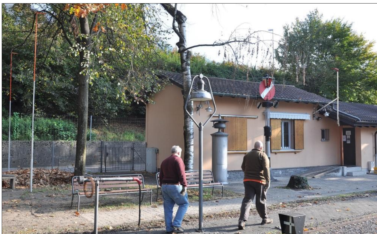
Sono visibili le modine che indicano approssimativamente gli ingombri del nuovo manufatto – 25.10.2014
