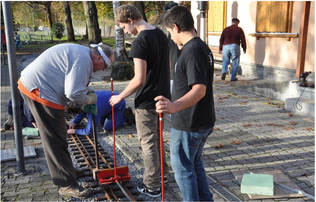
Allineamento dei binari
