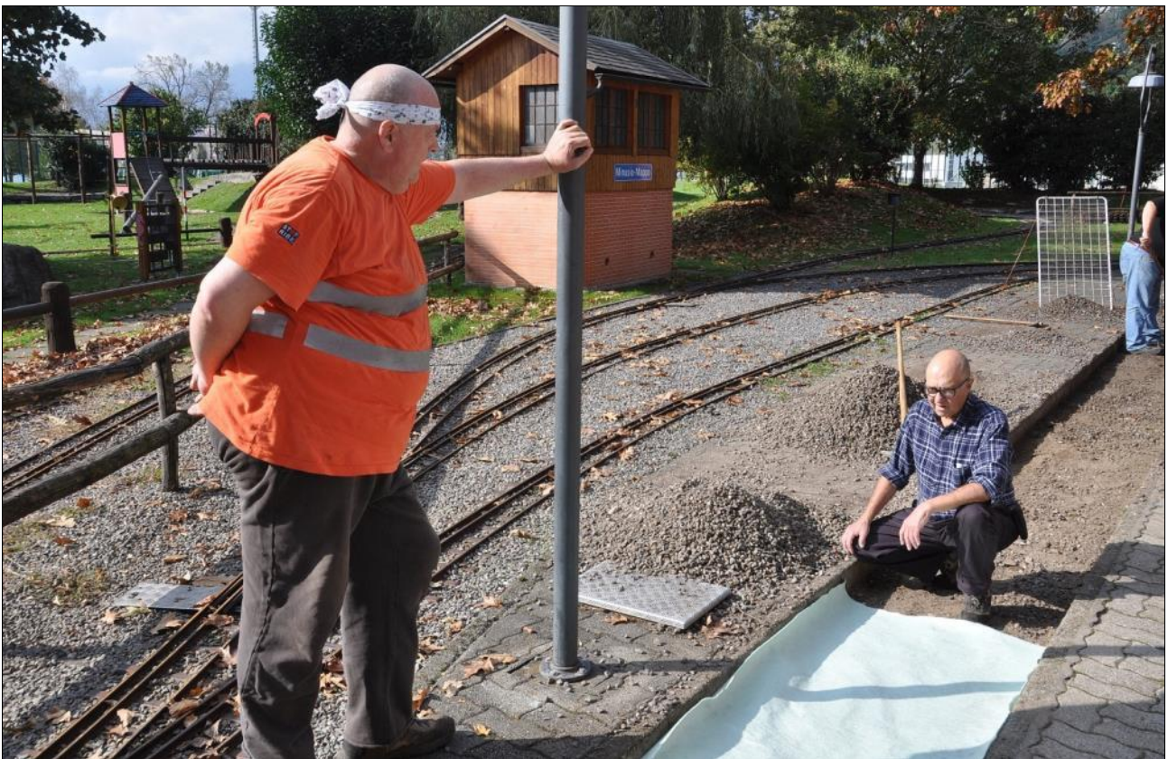
Danilo e Vittorio – pianificazione della posa del tappeto isolante
