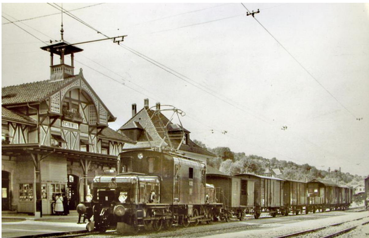
Beinwil 1926: viaggio di prova della De 6/6 15302 alimentata a 5'500 V/25 Hz (Archiv Verkehrshaus Luzern)
