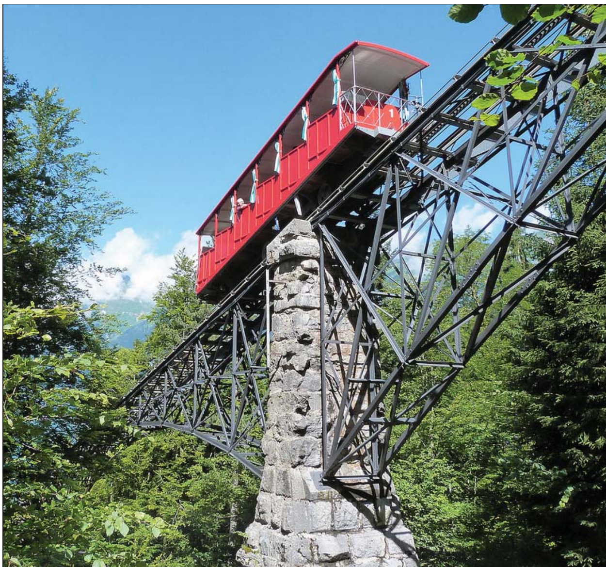
Genietete Fachwerkbrücke, entsprechend dem damaligen Stand der Technik
