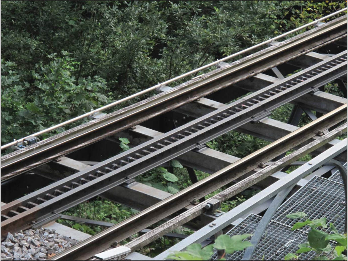
Sistema di freno a cremagliera secondo il sistema Riggenbach
