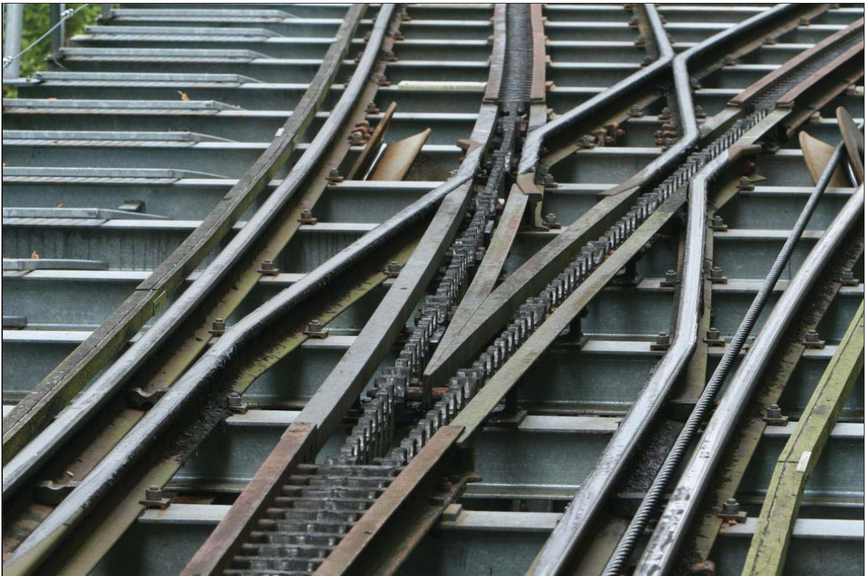
Sistema di freno a cremagliera secondo il sistema Riggenbach
