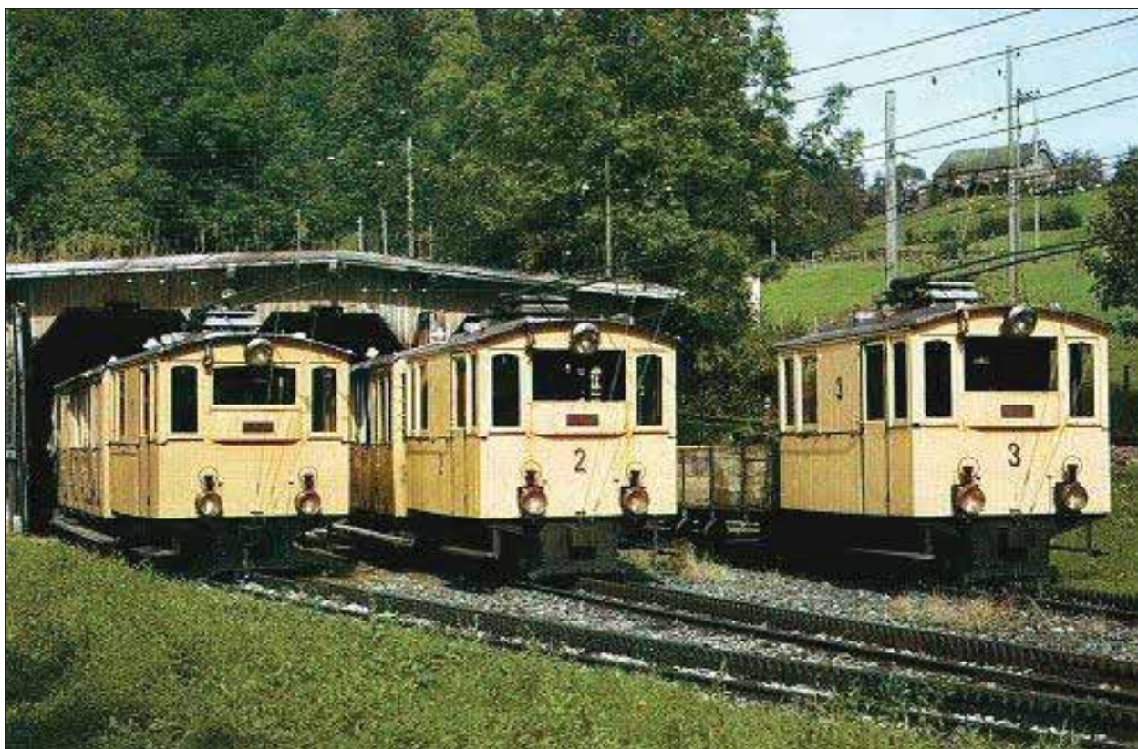
Il deposito a Morschach con il parco completo - 15.10.1967
