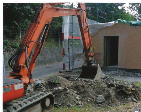
Il 27 settembre 2017 il tetto è stato demolito, iniziano i lavori di scavo.
