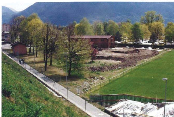
Inizio lavori per nuovo impianto a Minusio-Mappo.
