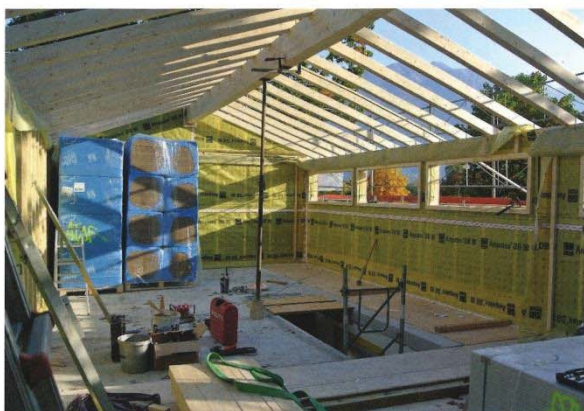
Il 1° piano è costruito con la tecnica del prefabbricato.
