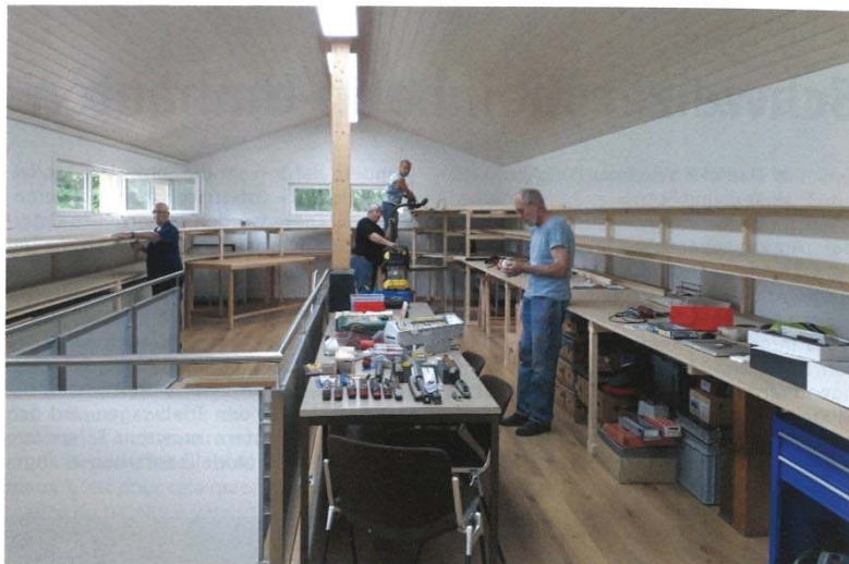
I primi lavori per la costruzione degli impianti nelle scale 0, I e II m.
