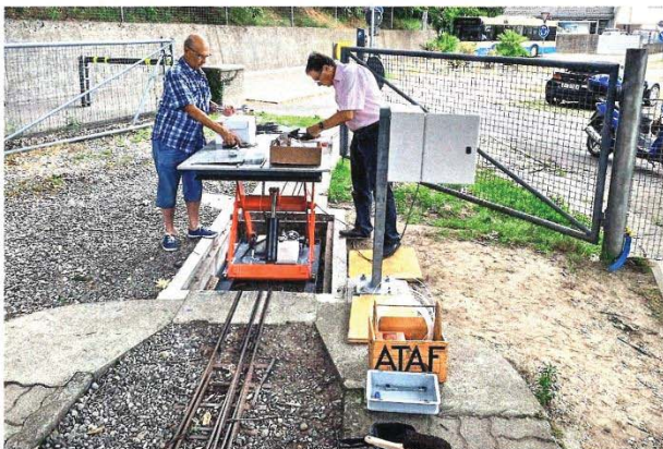
Elektrischer Anschluss und Prüfung des 1000-kg-Aufzugs auf der Ostseite.
