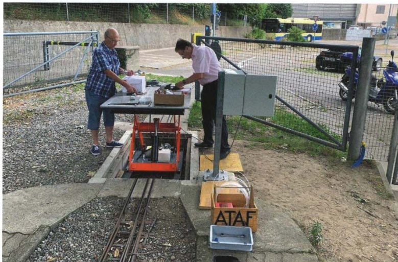
Allacciamento elettrico e collaudo del sollevatore lato est.
