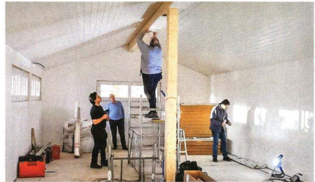
Ein Grossteil der Innenarbeiten wurde von ATAF-Mitgliedern geleistet.
