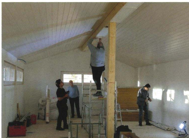
Buona parte dei lavori interni sono eseguiti dai soci ATAF.
